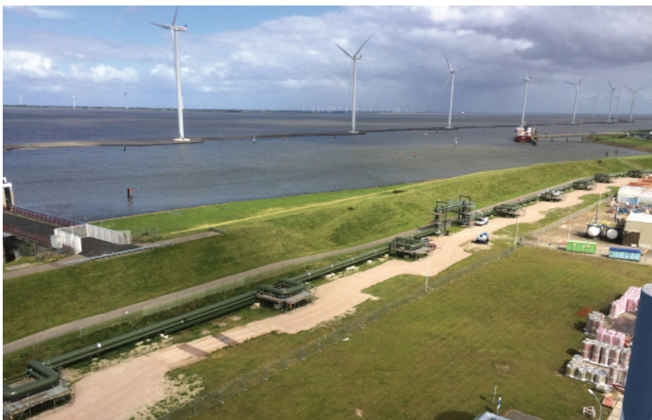
De groene stoom van Eneco wordt door buizen getransporteerd naar onze zoutfabriek
